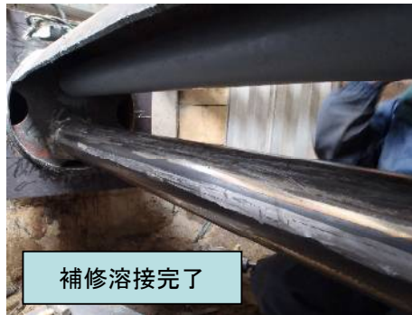
既設の埋設高温水配管(173°C 1mpa) 活管溶接で補修させていただきました。
