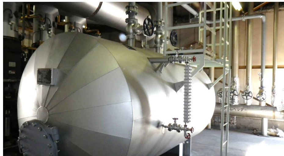
現場据付、配管工事状況
