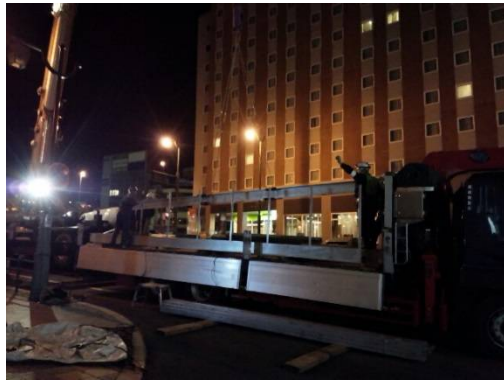
現場搬入は夜間工事
