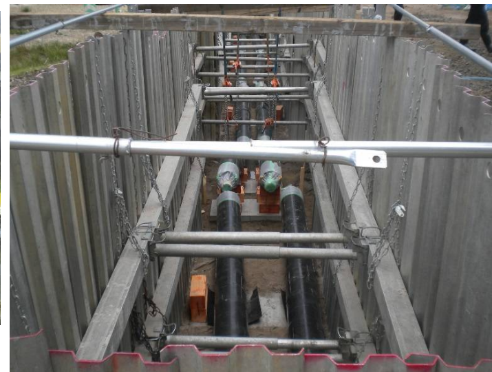
現場敷設状況
