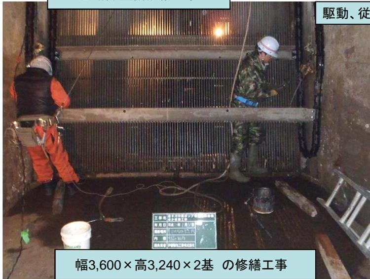
駆動、従動、掻揚スロケット交換 チェーン320リンク(約12m片側)交換
