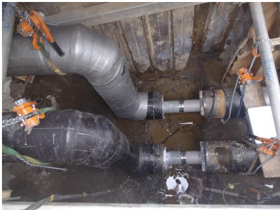
加工管の現場敷設状況
