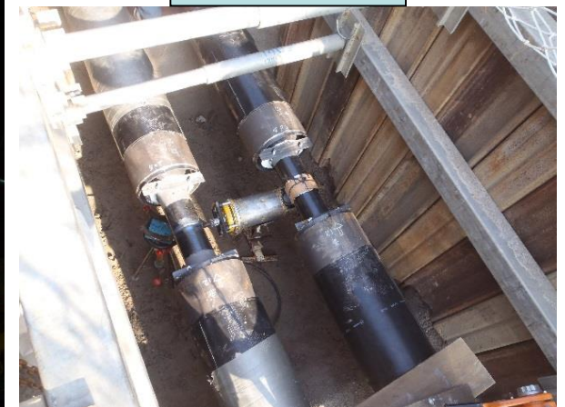
現場でRT検査
