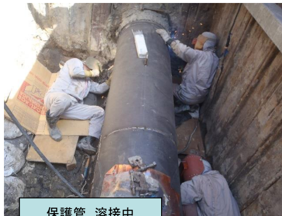
保護管 溶接中
