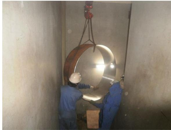
地下3階への搬入経路 幅MIN 850W 高さMIN 2,000H
