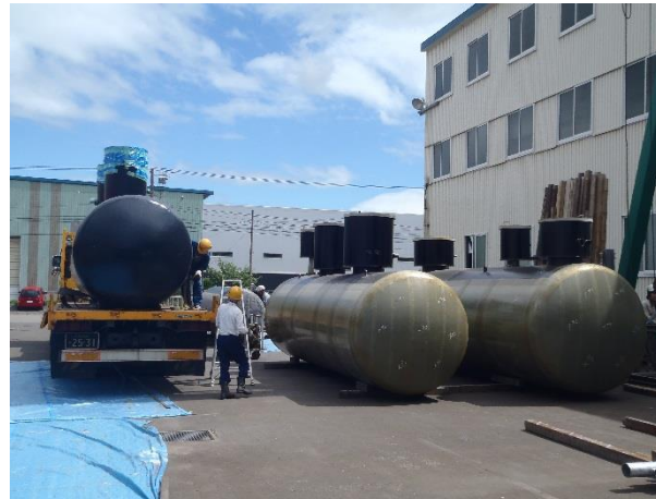
左から 8KL エポキシ塗装 20KL×2基 SFタンク
