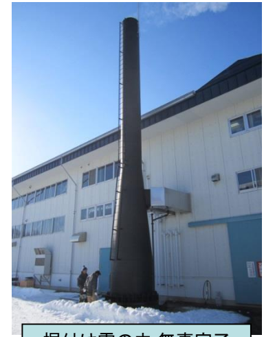
据付は雪の中 無事完了
