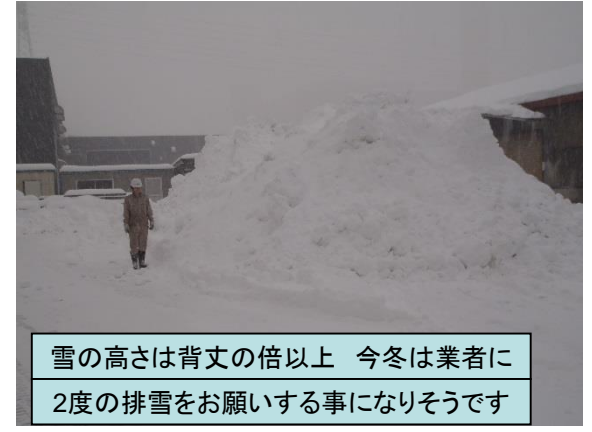
クレーンヤードに除雪した雪を積み上げます
