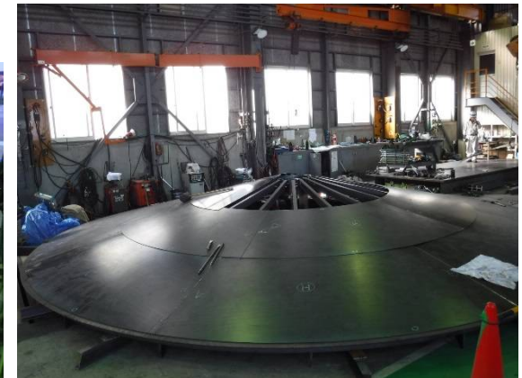
天板 仮組状況
