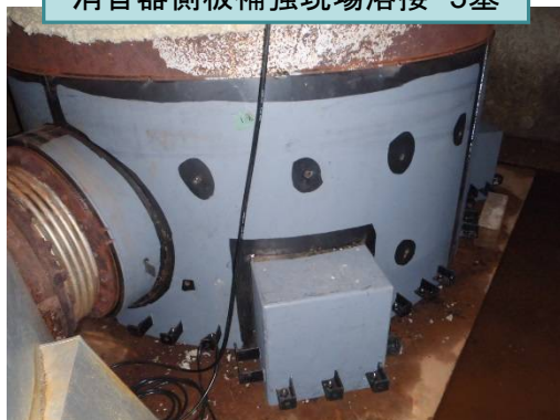
消音器側板補強現場溶接 3基
