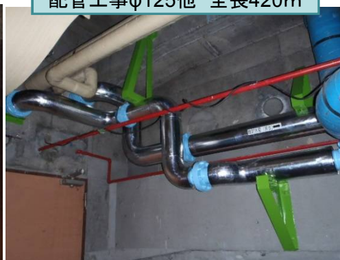
配管工事φ125他 全長420m
