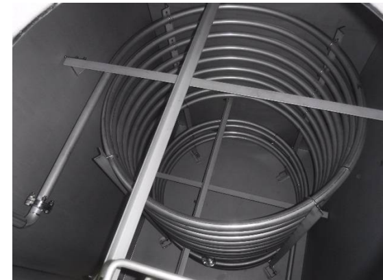
温水加熱コイル タンク内部設置状況
