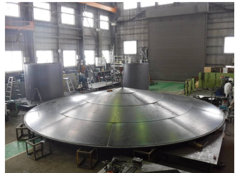
仮組、確認完了
