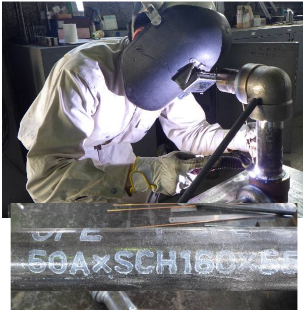
熱供給配管工事 2重管プレハブ加工後、現場溶接(RT検査仕様)施工させて頂きました
