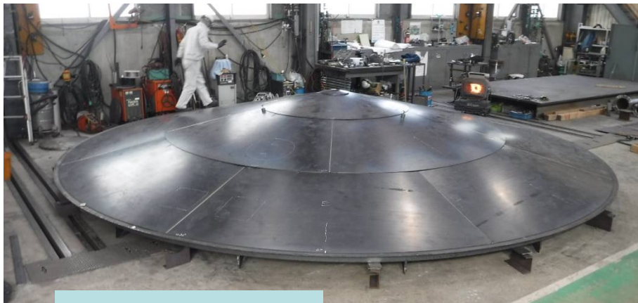
屋根 仮組状況
