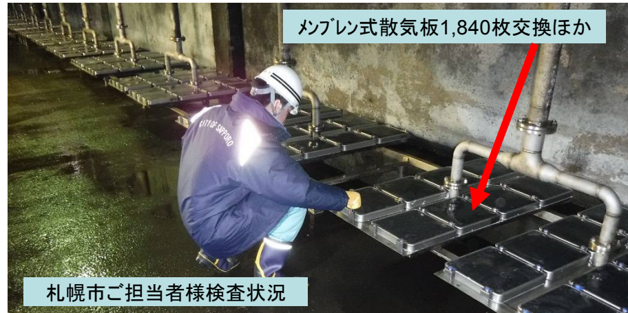
札幌市様発注 当社元請施工(昨年とほぼ同様の工事) 新川水再生プラザ第1処理施設1系反応タンク散気板装置ほか修繕工事
