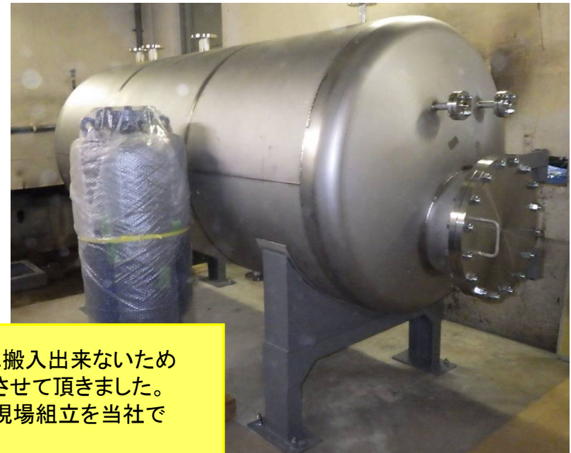
現場組横型貯湯槽 工場製作完了
