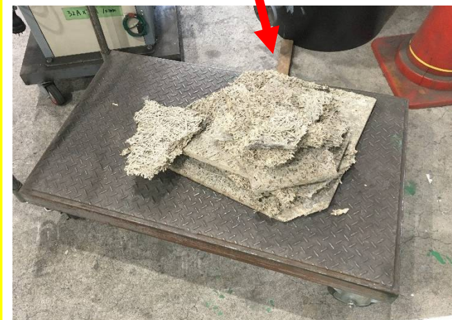
剥離 落下した木毛版
