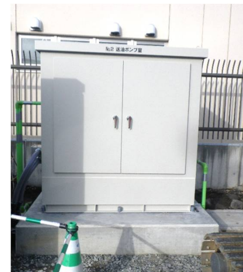
配管、ポンプ小屋完成
