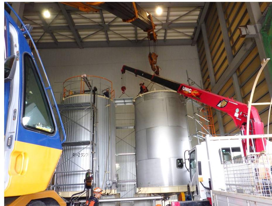
昨年に引き続き 糖蜜タンク 設計製作、既設撤去、新規据付させて頂きました
