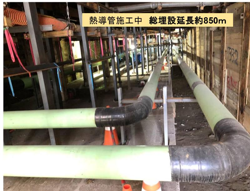
熱導管施工中 総埋設延長約850m
