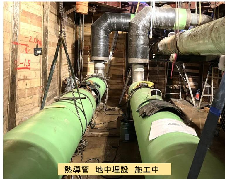
熱導管 地中埋設 施工中
