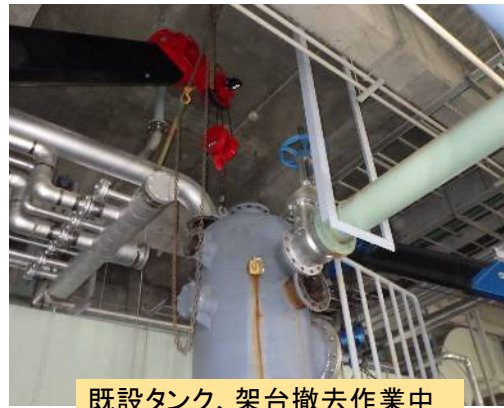
既設タンク、架台撤去作業中
