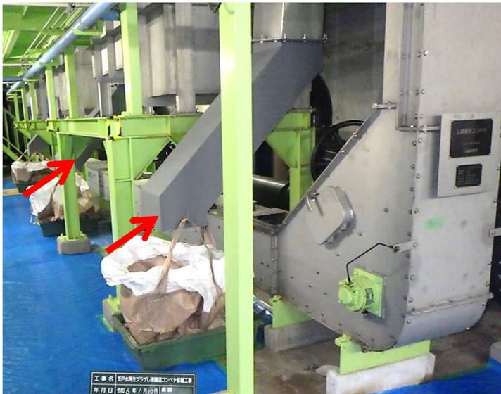
施工中に発生するし渣を受ける仮設シュートを取付
