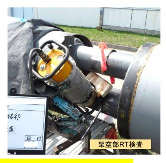
地域熱供給用 2重管の工場内作、各種架台の設計製作及び 現地据付、溶接を含む施工をさせていただきました 架空部 総延長195m 埋設部 総延長430m
