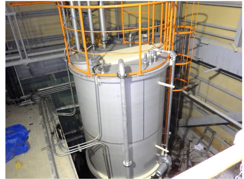
既設糖蜜タンクの撤去と新規タンクの設計、製作 現地据付、配管更新、保温工事を 施工させて頂きました
